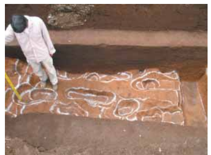
路面の下を掘ると、道路を造ったときの基礎工事の跡が。かなり凹凸があります
